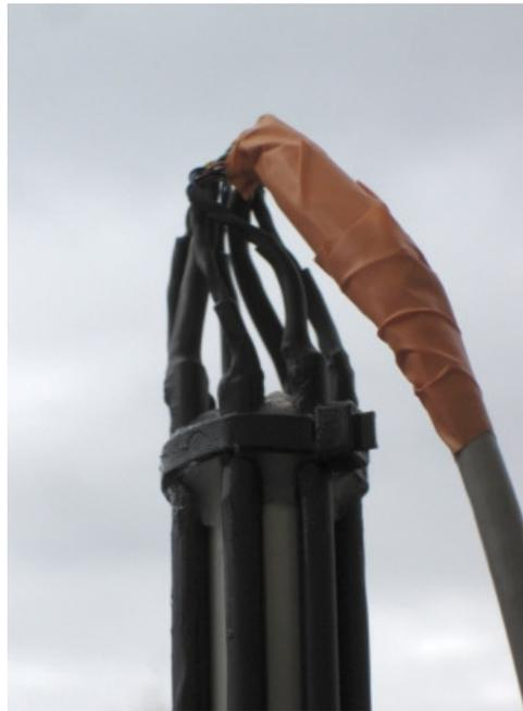
Connexions réalisées à l'aide de dominos puis isolées avec de la gaine thermo-rétractable
